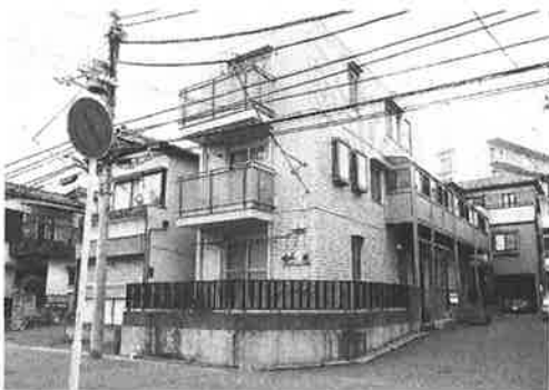
増改築部分が台無しにしている集合住宅
